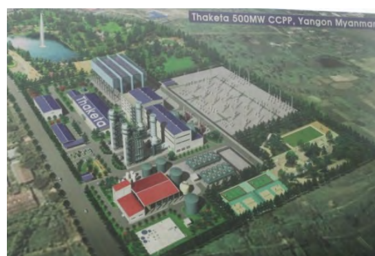
Thaketa 500MW GTCC
